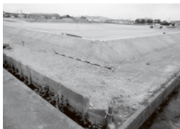
みなと小学校建設予定地 (4月2日現在)
